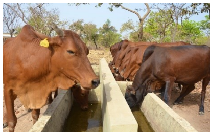
Abrevoir construit par la Suisse dans le domaine du DERL. _© Coopération suisse au Bénin
