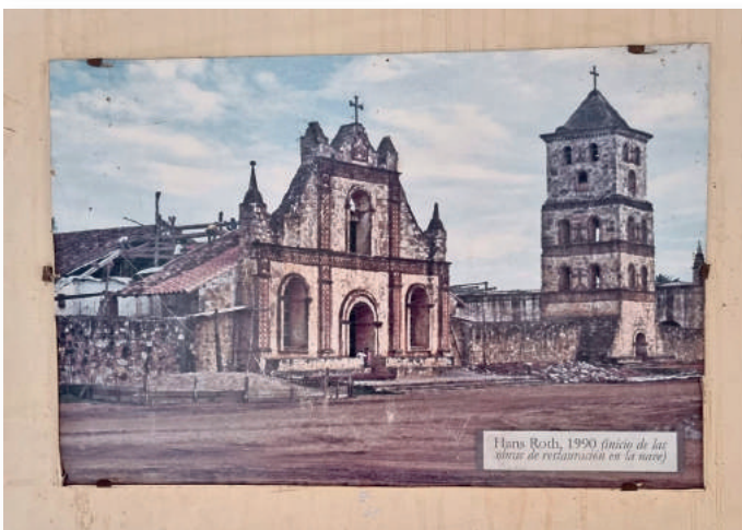
12: La iglesia de San José al inicio de las obras de restauración en 1990.
