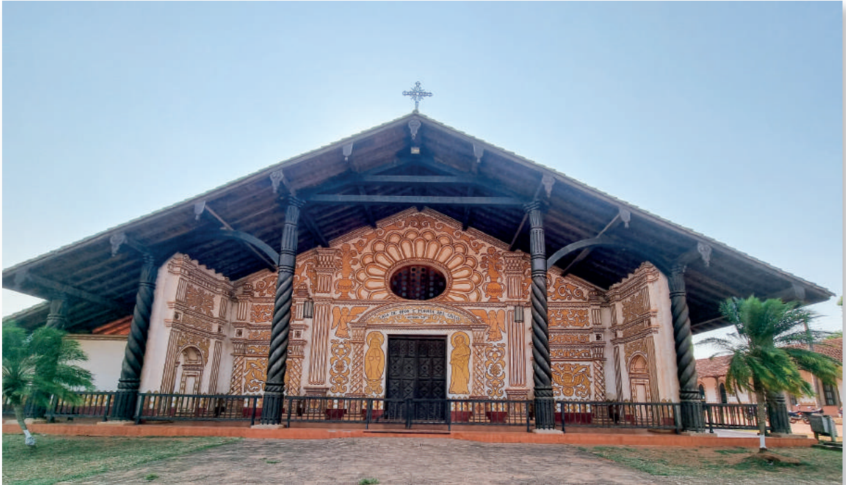
1: Iglesia de la Concepción. El armazón es de madera y las paredes de tierra seca (aquí decorada), como en las viviendas indígenas.
