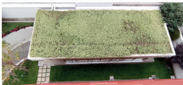
10: La salle de conférence construite en 2015 ; le toit végétalisé permet de la considérer comme un espace de jardin et de respecter ainsi la législation locale.
