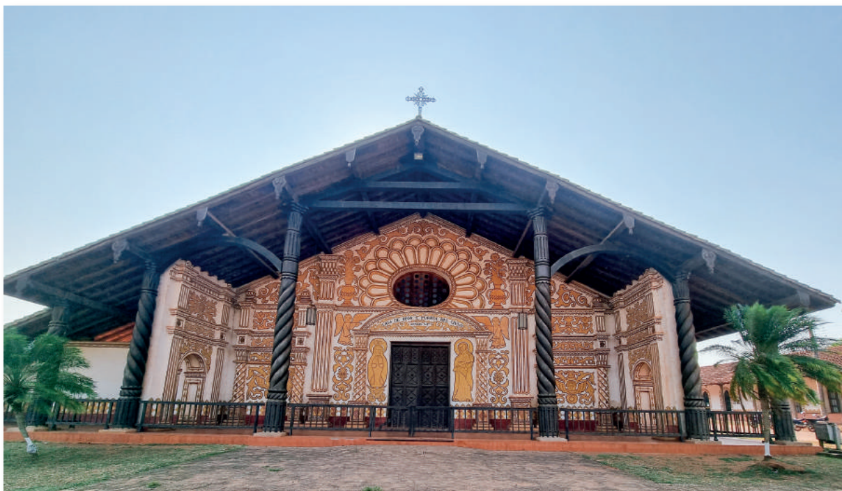
1: Église de Concepción. La charpente est en bois et les murs de terre séchée (ici décorée), comme dans les habitations indigènes.
