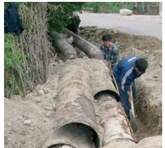
Erneuerung des Verteilnetzes in Khujand (Foto: SECO)
