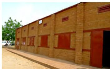
Les innovations technologiques pour les infrastructures éducatives (classes en terre stabilisée) et hydrauliques (réservoirs en tôle noire),
