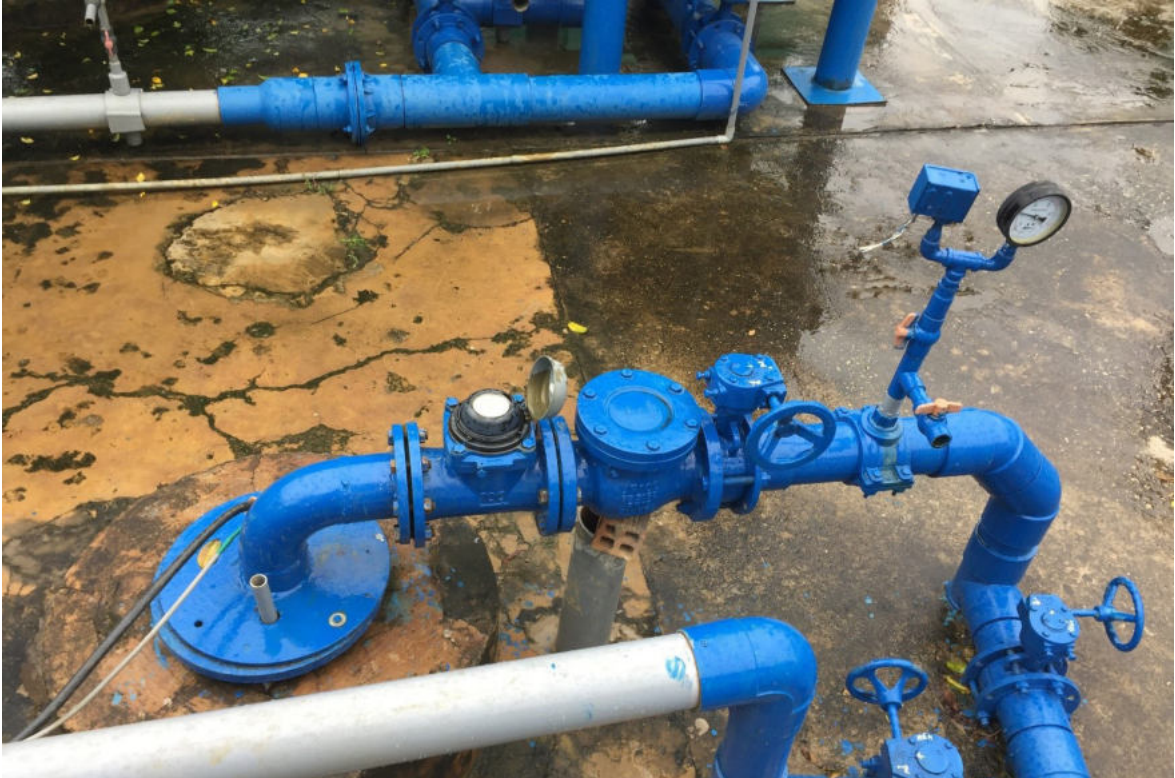
Hình 37: Đầu nối bơm nước ngầm trong cấp nước sạch thương mại tại Cà Mau (Ảnh từ BGR)
