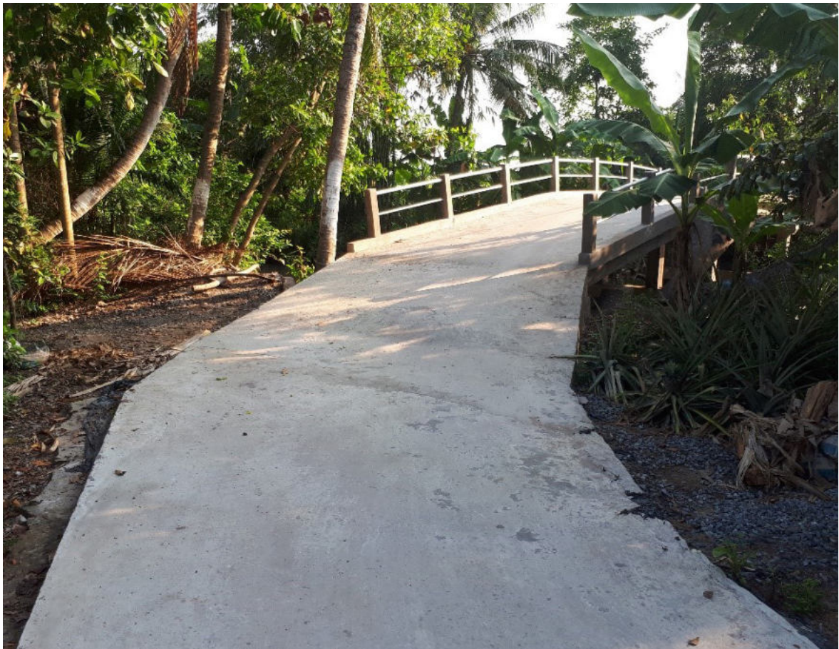
Hình 25: Cây cầu được xây dựng trong thời gian gần đây có kết nối liền mạch với các tuyến đường nối. Chưa quan sát thấy sụt lún nền đất.
