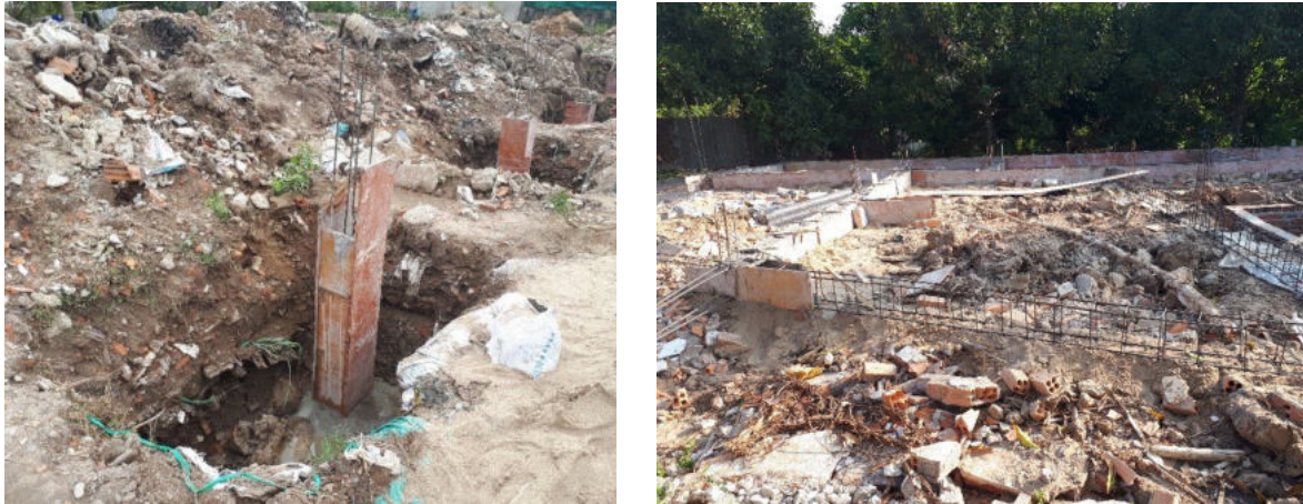
Hình 21: Trái: móng cọc của một tòa nhà ở Cần Thơ – chiều sâu khoảng 1m; Phải: tường không có móng
