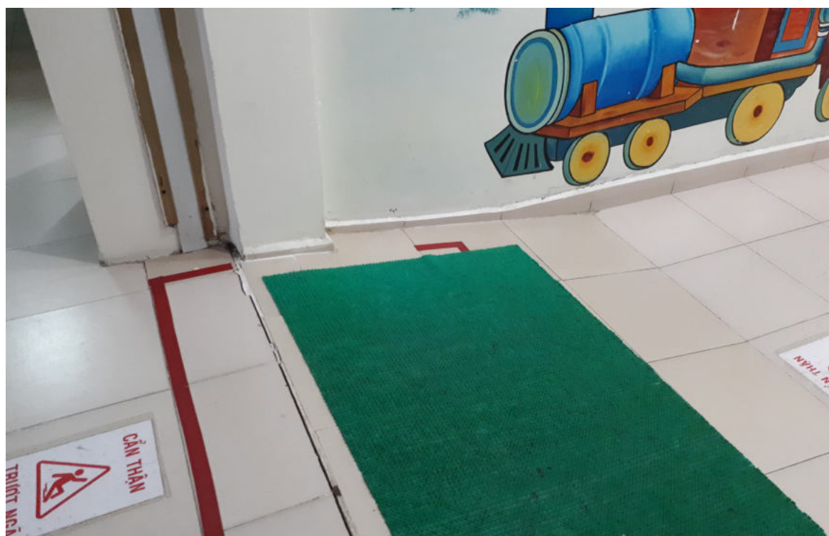
Hình 32: Sàn nhà phía bên phải và phía bên trái nằm trên một mặt bằng khi Bệnh viện tại Long Xuyên được xây dựng
