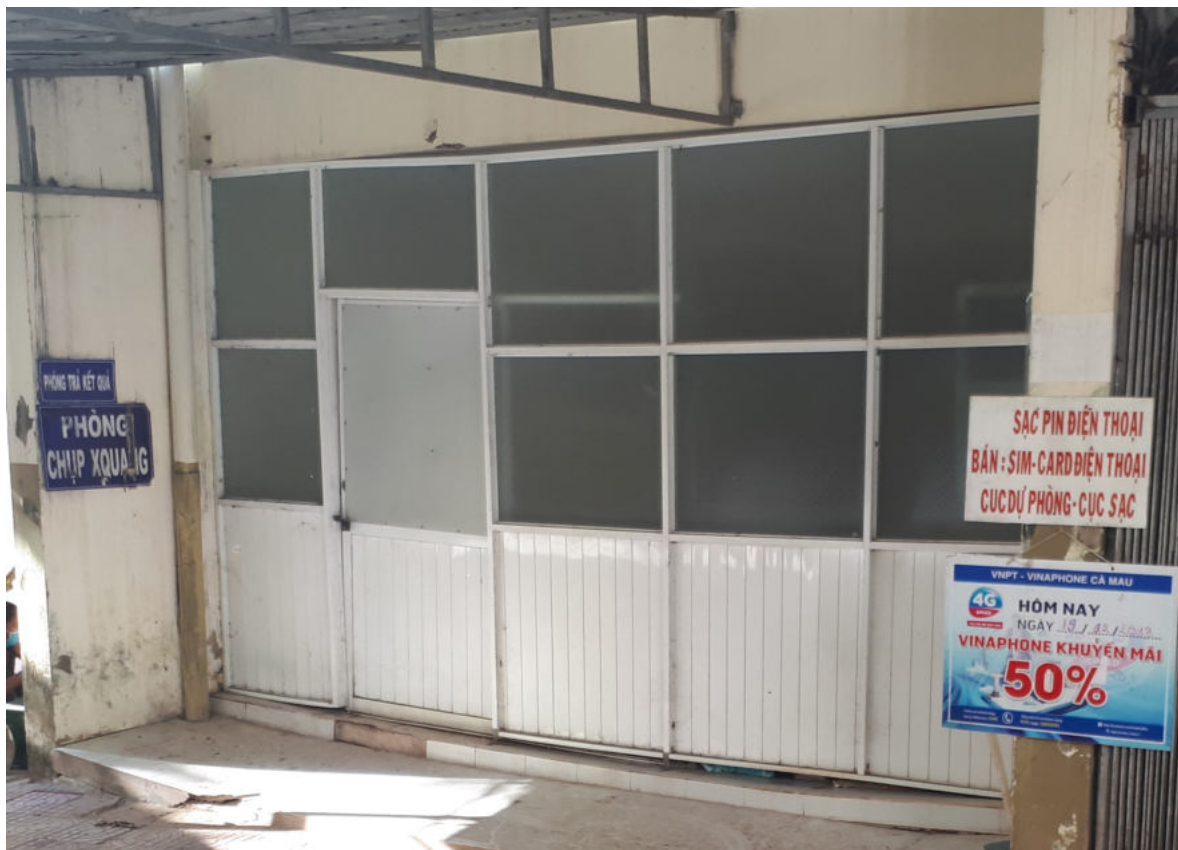
Hình 31: Phần giữa của sàn nhà lún xuống nhanh hơn phần tường tạo ra các khoảng trống giữa phần chia tách cửa sổ, cửa chính và sàn (một bệnh viện tại Cà Mau).
