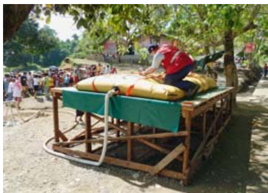
Während der Ingenieur Urs Rupper (links) mit Kollegen die Schäden an einer Wasserleitung analysiert, richtet Teamleiter Claudio Valsangiacomo (oben) einen mobilen Kunststoff-Wasserspeicher ein
