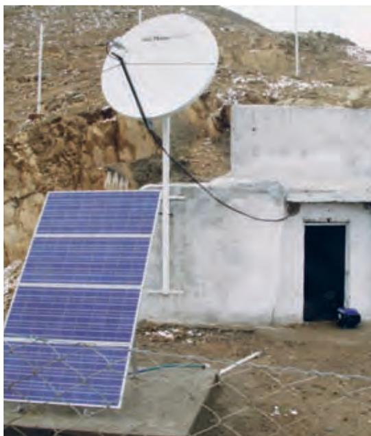
Una estación para monitoreo sísmico conectada por banda ancha satelital.
