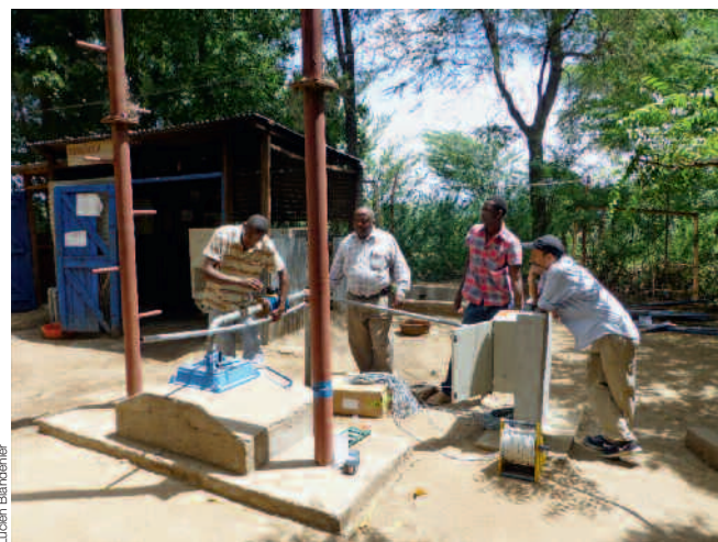
Des techniciens kényans installent l'appareillage nécessaire au contrôle de la nappe phréatique se trouvant sous le camp de réfugiés de Dadaab. Les données recueillies sont envoyées en Suisse par le réseau GPRS.
