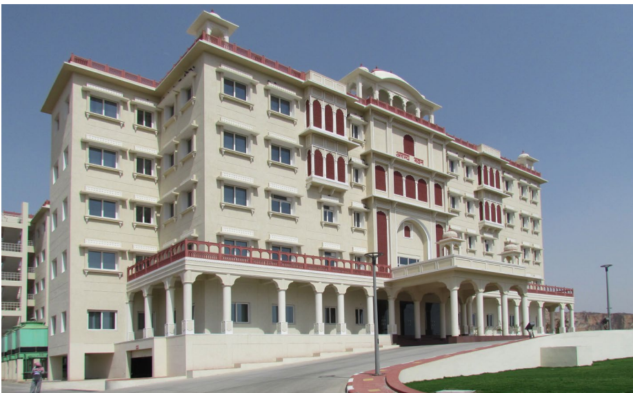
L'edificio costruito per il Servizio forestale dello Stato del Rajasthan a Jaipur può fungere da modello. Il suo consumo di energia è inferiore del 50% a quello previsto dal marchio «cinque stelle» sviluppato dall'Ufficio indiano per l'efficienza energetica. © BEEP
