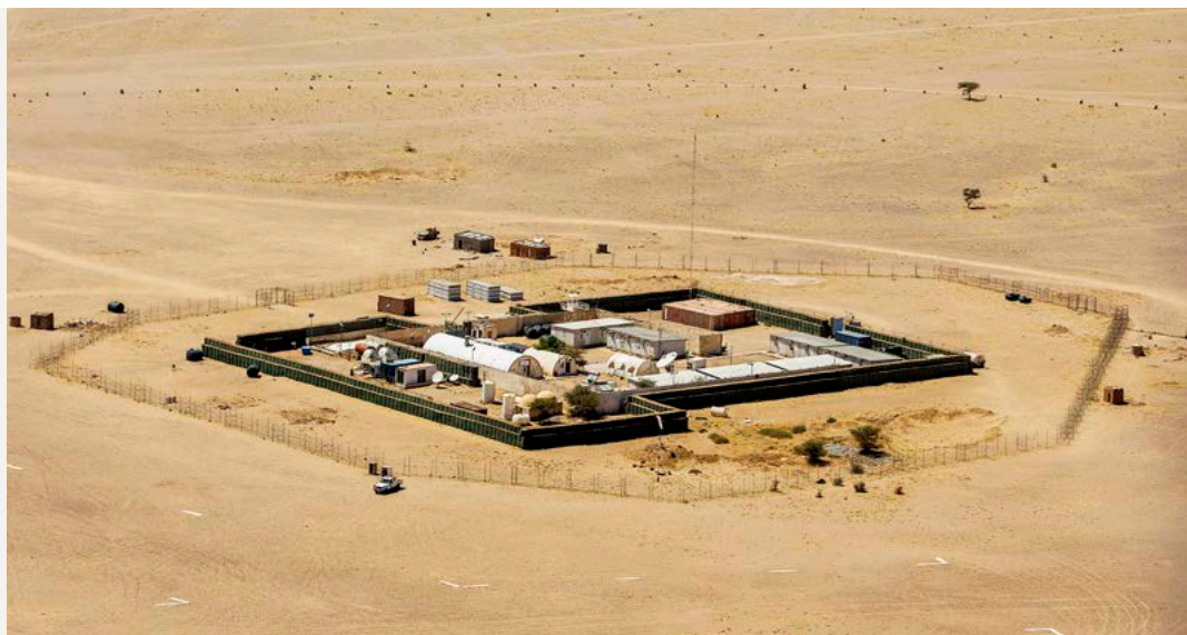
Die Team Site von Bir Lahlou, aufgenommen im Landeanflug aus dem Helikopter, welcher die Versorgung sicherstellt.
