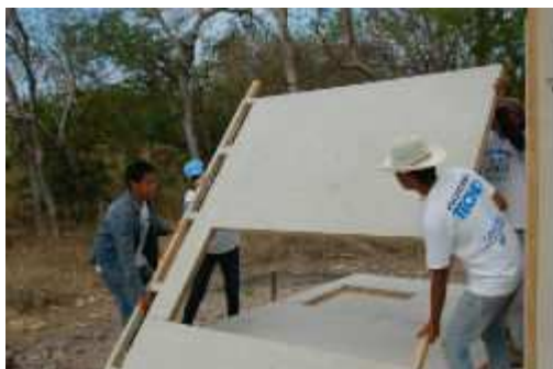
Bau der Holzhütten des TECHO-Projektes in El Salvador
