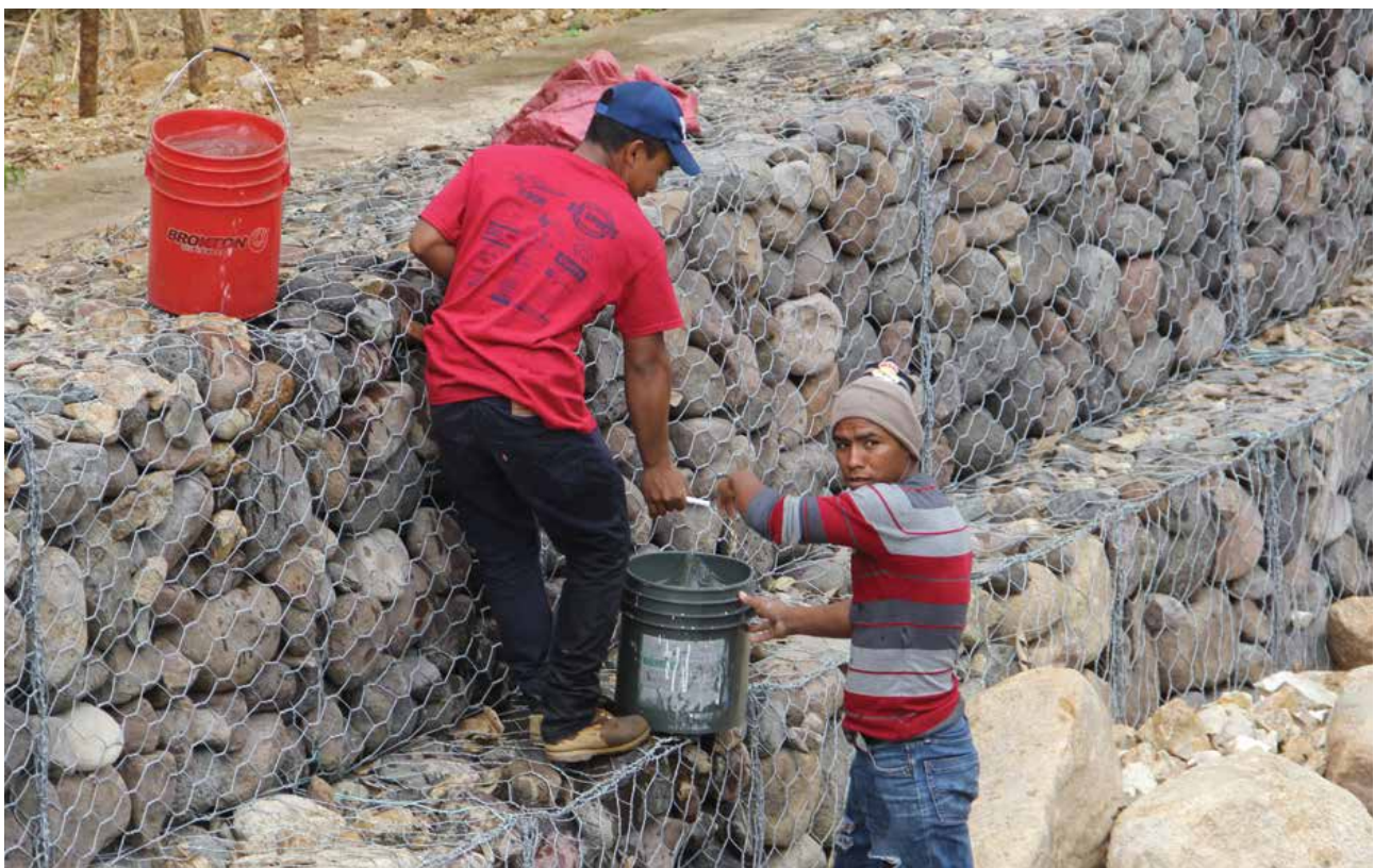
Instandhaltungsarbeiten in Dipilto, Nueva Segovia, Nicaragua. Foto: DEZA.
