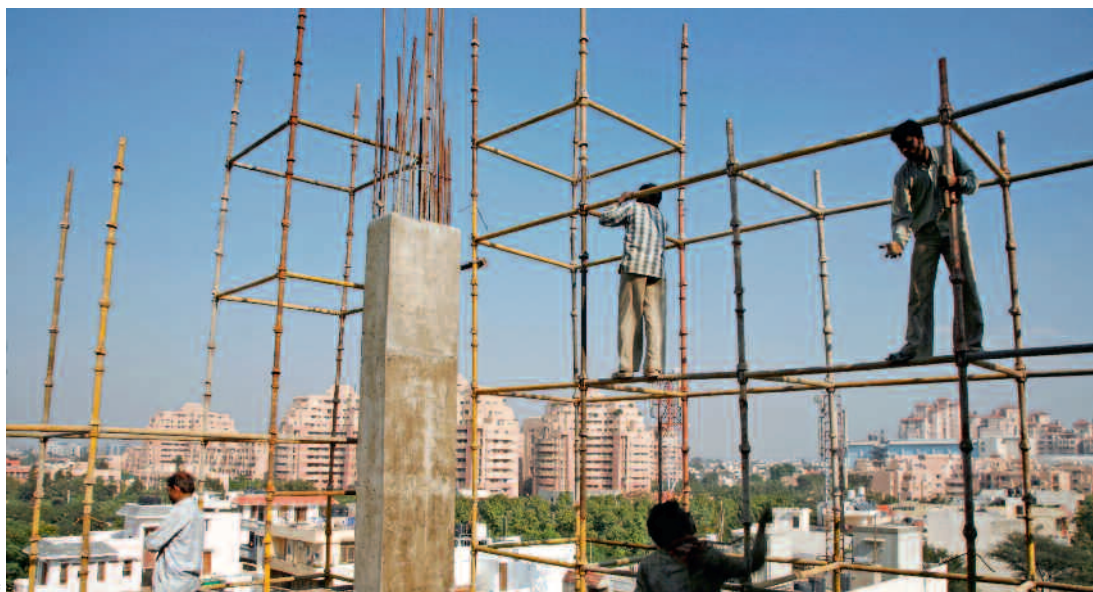
Baustelle in Gurgaon, einer Satellitenstadt im Südwesten der indischen Hauptstadt Delhi. Der Bauboom stellt das Land vor grosse Energieprobleme.
