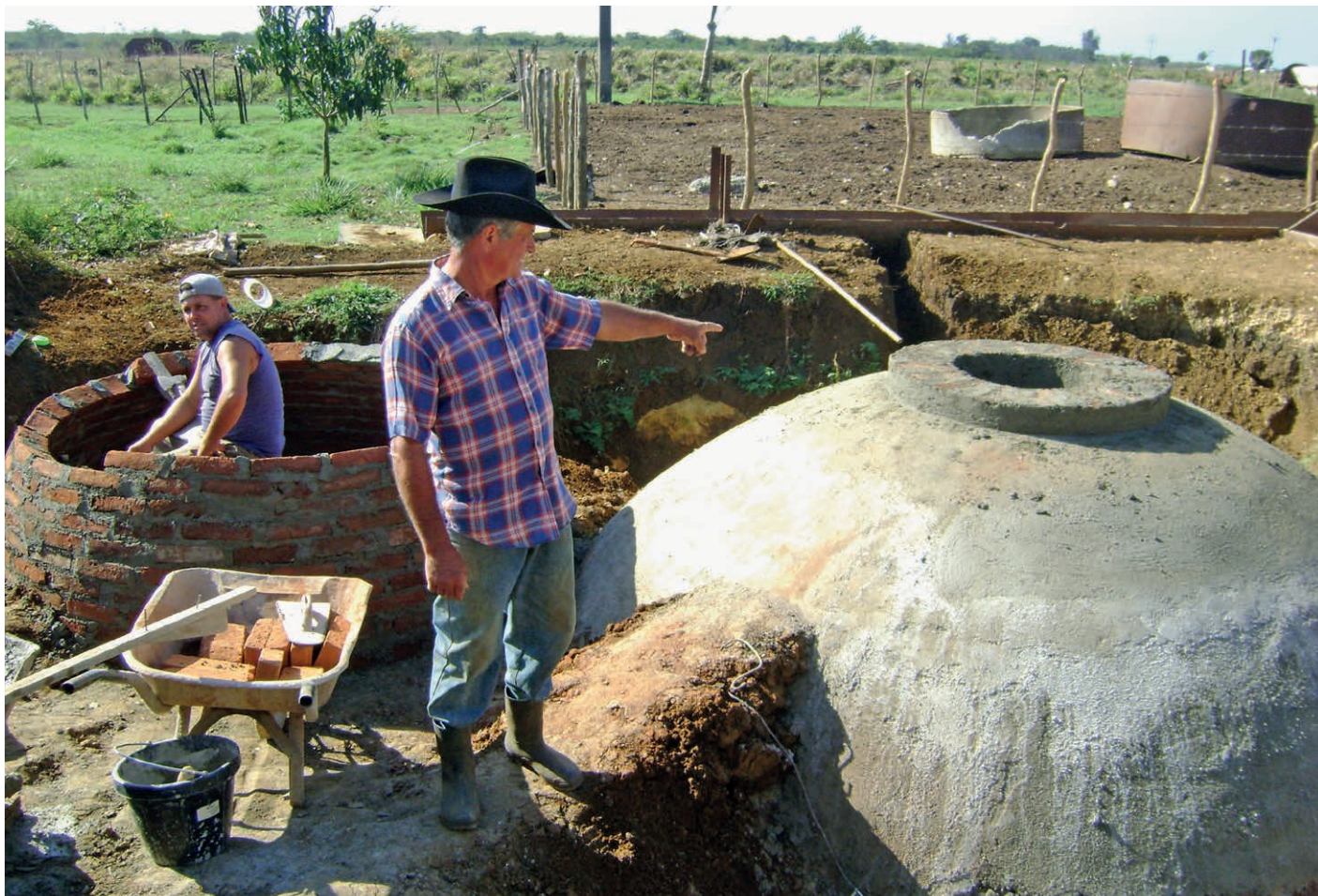
Los pequeños agricultores cubanos se benefician de los biodigestores para eliminar purines y producir gas para el autoconsumo
