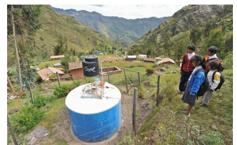
Système de chloration d'eau potable approuvé par SABA. District de San Salvador, région de Cusco. Photo DDC
